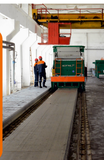
Формование плиты перекрытия
