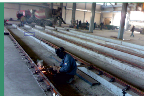
Процесс реконструкции цеха
