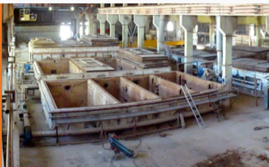
Цех до реконструкции
