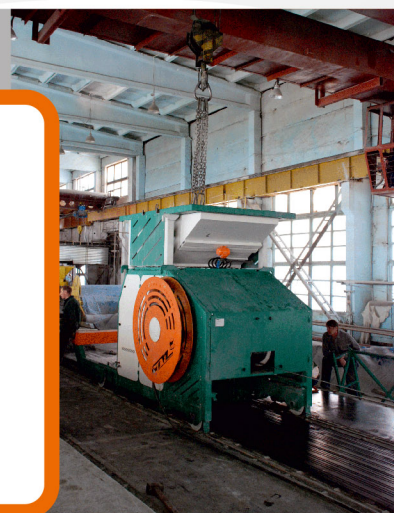
Формование плиты перекрытия
