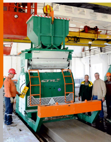
Установка бункера-наполнителя на формующую машину
