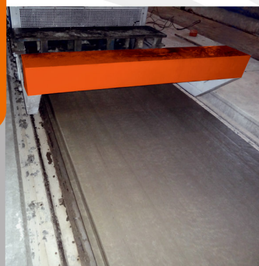
Процесс изготовления пустотных плит перекрытий
