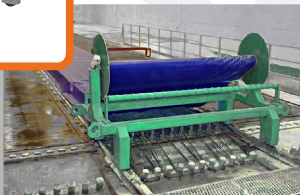
Раскладка защитного покрытия
